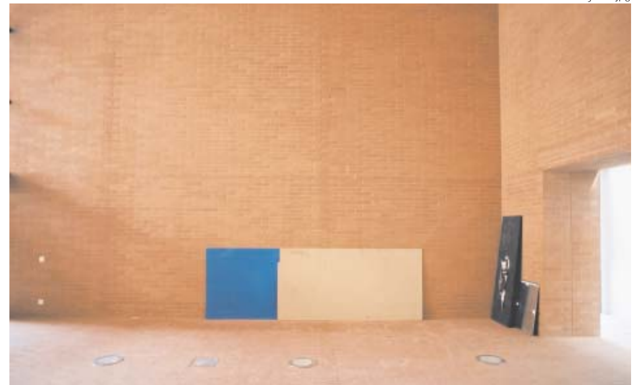
Wenn schon Ziegelgewölbe, dann echt Altbau, sonst: Stahlbeton.
